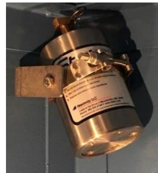
Aerosol blussysteem in brandveiligheidskast
